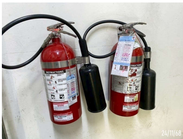
ถังดับเพลิงเคมี (Chemical Fire Extinguisher)
